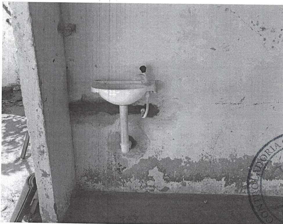
Foto 12- Colocação de Lavatório Louça
