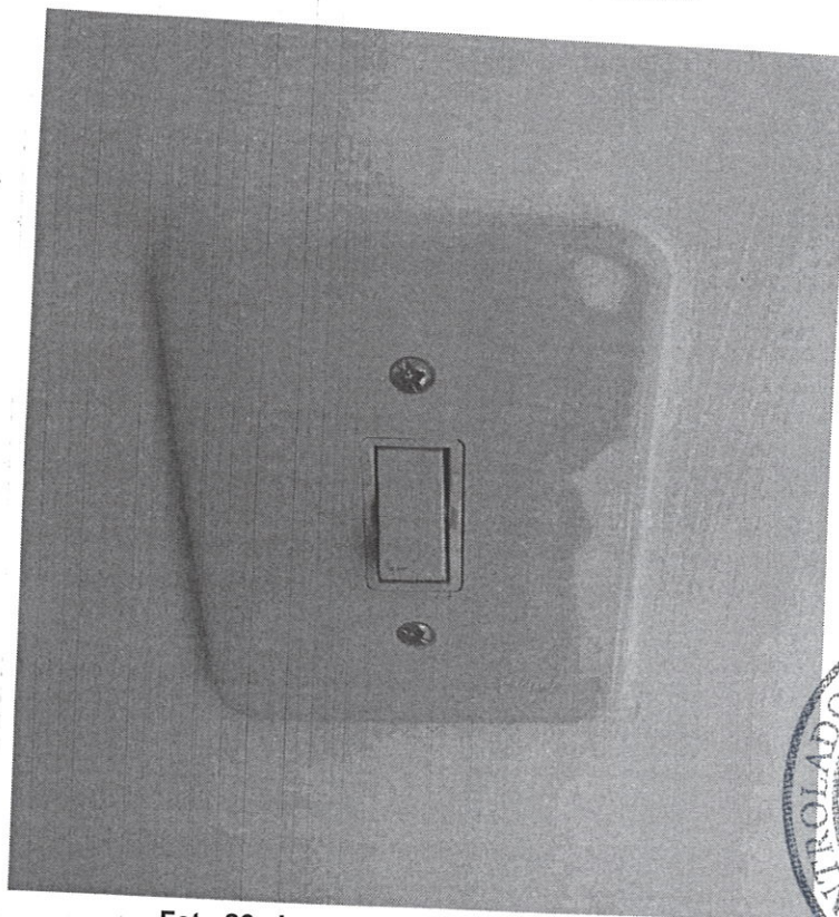
Foto 26- Instalação Interruptor Simples
