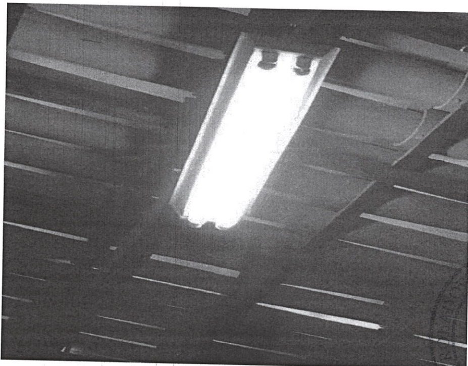
Foto 20- Colocação de Lampada Tubular
