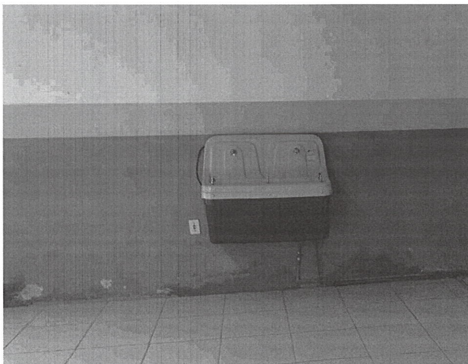
Foto 09- Revisão e Manutenção Hidráulica
