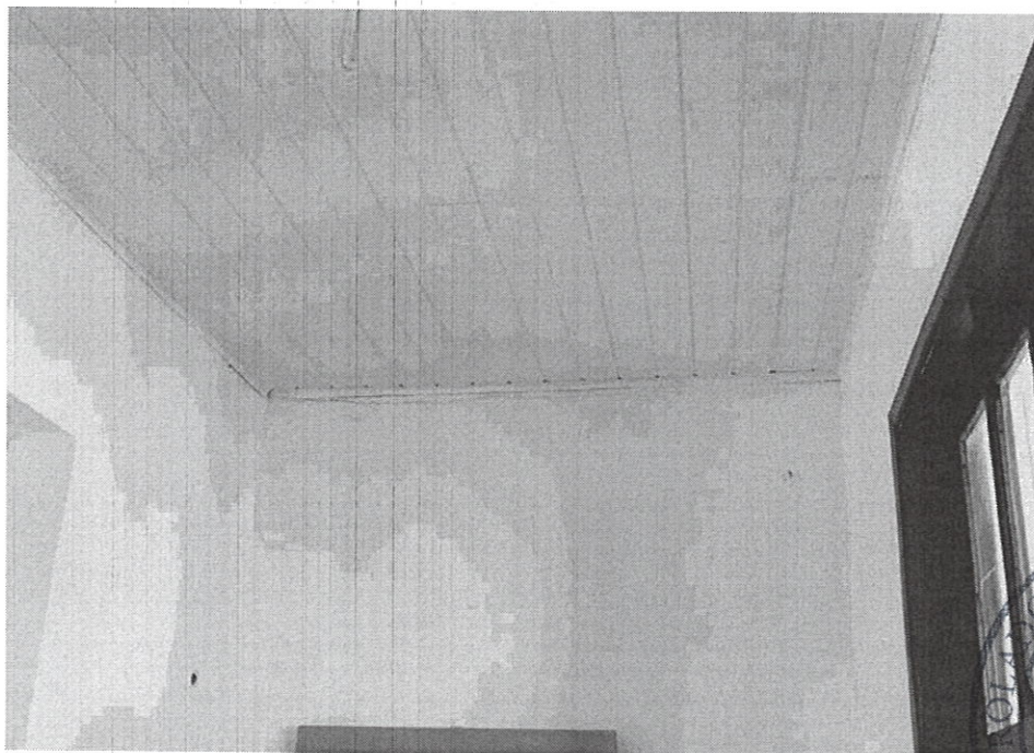
Foto 06- Revisão e Colocação de forro em PVC
