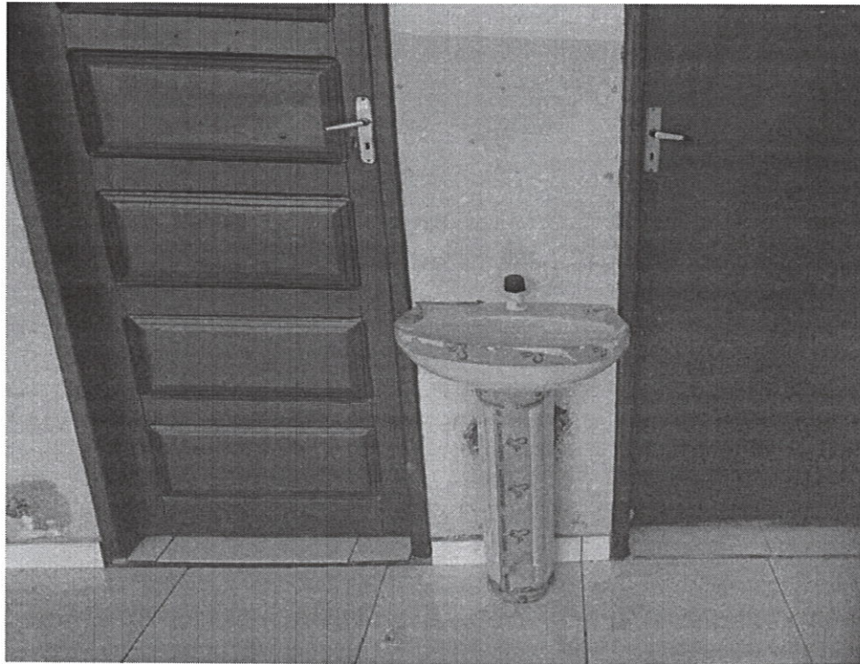
Foto 17- Colocação de Lavatório Louça
