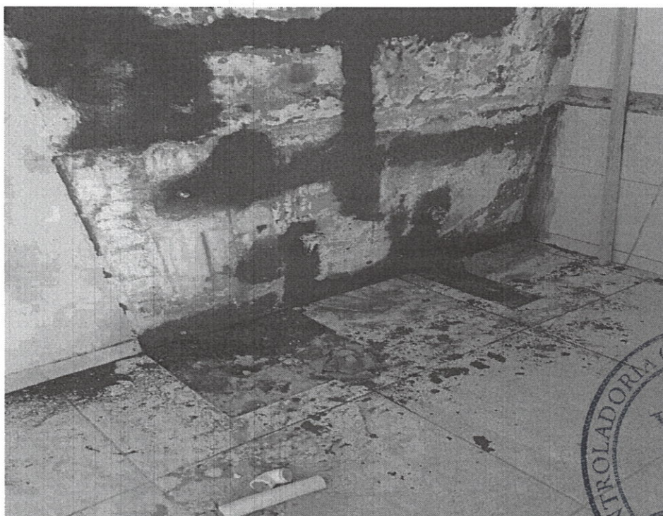
Foto 10- Revisão e Manutenção Hidráulica
