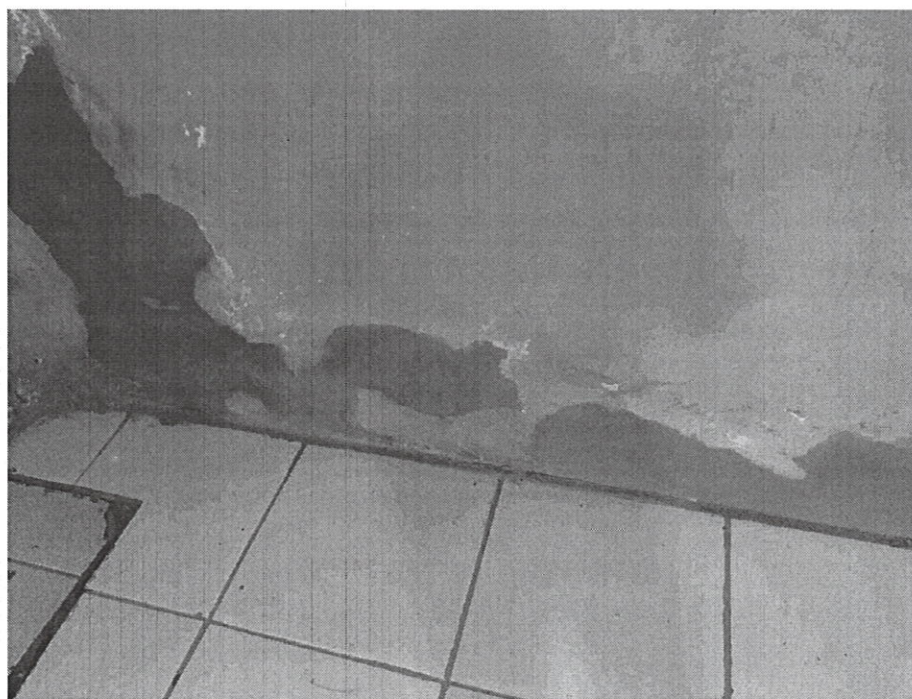
Foto 01- Reparo e reboco em superfície
